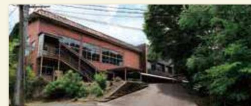
金管練習棟、西館から急斜面を上ると大講義室に到着。北館もすぐそば。
