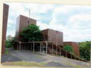
南館～食堂～売店などあった建物、急斜面にあった階段を幾度となく通った方も多いかと思います。
