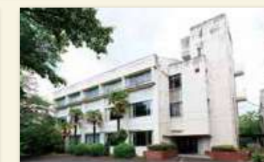
西館。比較的新しい教室が4室設置。またレッスン室も多く配置されていました。レッスンや講義で訪れた方も多いのではないでしょうか。
